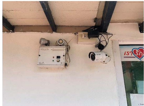
ภาพที่ 2.2-16 ระบบไฟฟ้าส่องสว่างฉุกเฉิน
