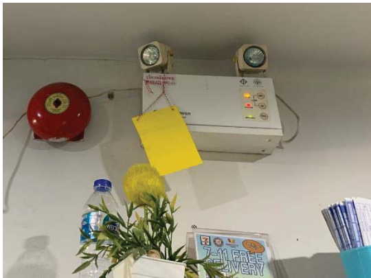
ภาพที่ 2.2-16 ระบบไฟฟ้าส่องสว่างฉุกเฉิน
